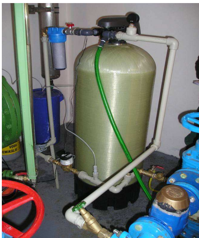
Obr. 4. Instalace provozní úpravy malého zdroje (0,3 l/s) filtrací na GAU s následnou chlorací v prameništi B
